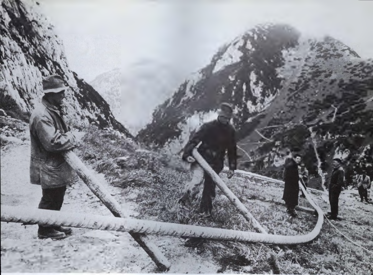
Fernseh-Sender Wendelstein: Transport eines Hochfrequenz-Kabels zum Gipfel (1954).
