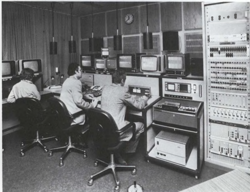
Blick in den Regieraum des Studios, das am 1. 12. 1978 den Betrieb aufnahm.
