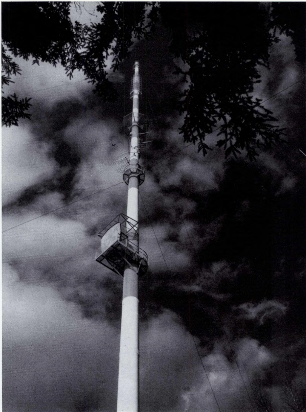
Seit 29. November 1972 in Betrieb: der neue Fernseh-Grundnetzsender »Hohe Linie« bei Regensburg. Der 145 Meter hohe Rohrmast trägt Antennen für das 1. Fernseh- und das 2. Hörfunkprogramm. Gesamtkosten: 3,2 Millionen DM
